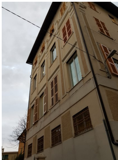
Figura 1.1 - Vista della facciata esposta a Sud-Est
